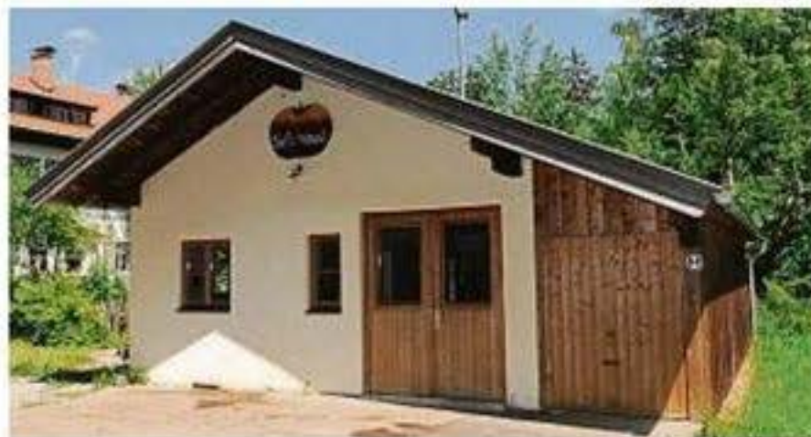
Klein, aber brisant: Die Unterkellerung der Gotzinger Obstpresse soll wegen der Wasserschutzzone nicht möglich sein. Die Gemeinden im Mangfalltal wollen dieses behördliche Votum nicht hinnehmen. FOTO: AL-ARCHIV
